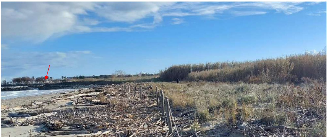
Fig. 1 – Confronto 2022 vs 2023 della spiaggia a sud, nei pressi del molo che separa la Riserva con la foce del Tronto. Le frecce rosse indicano la fine della parte calpestabile in terra del molo; si noti come il mare si sia spinto verso l'entroterra e conseguentemente la forte riduzione della spiaggia.
